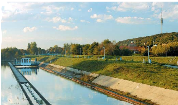
Versickerungsbecken zur Grundwasseranreicherung
