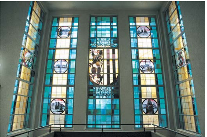
Fenster in der Filterhalle
