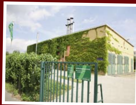
2 Blockheizkraftwerk Radebeuler Straße 4
