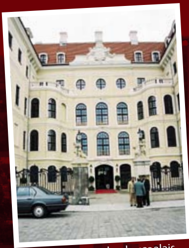
4 Kälteanlage Taschenbergpalais Kleine Brüdergasse 1
